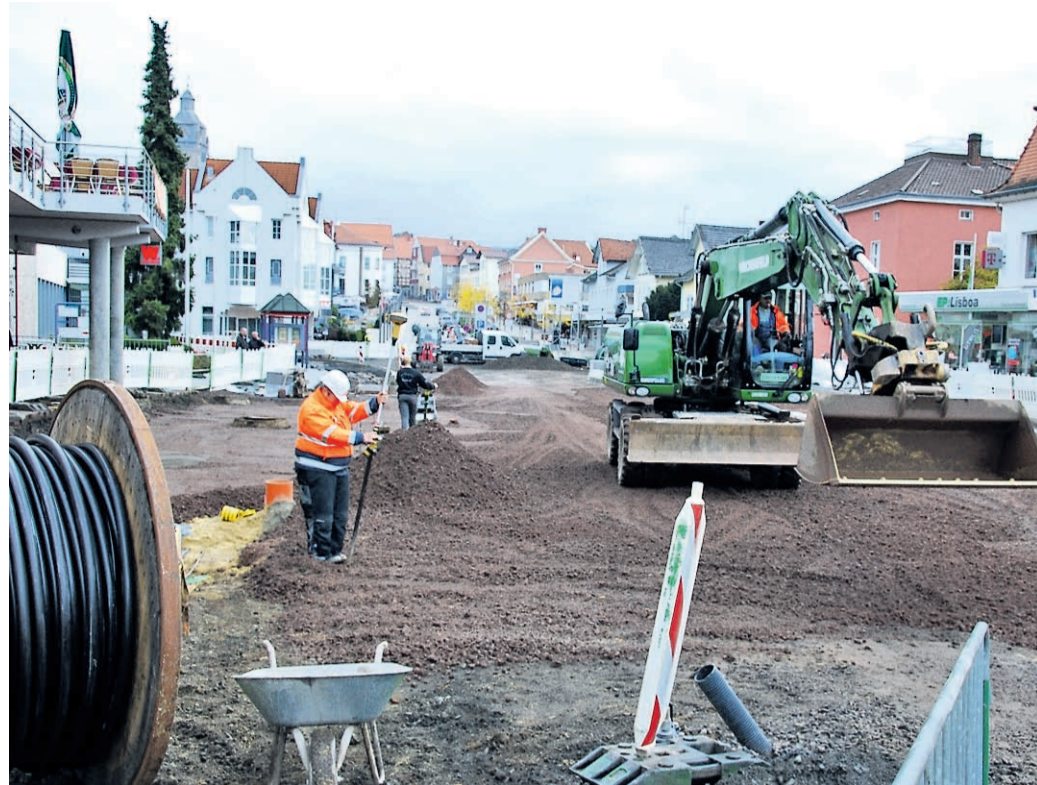
Im Sommer noch Großbaustelle – inzwischen rollt der Verkehr am neuen Bad Wildunger Scharnier. Foto: Conny Höhne
