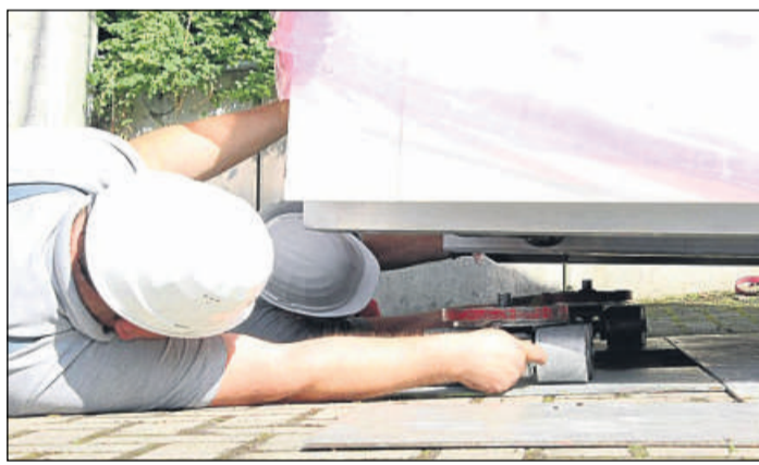
Transportvorbereitungen: Um das sechs Tonnen schwere Gerät ins Gebäude zu bewegen, wurden kleine Rollen untergelegt.
